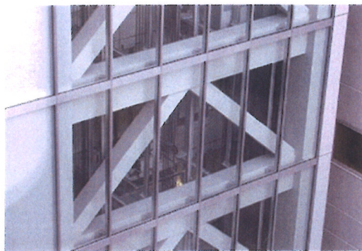
事務所ビル・EVシャフト（ブレース）
